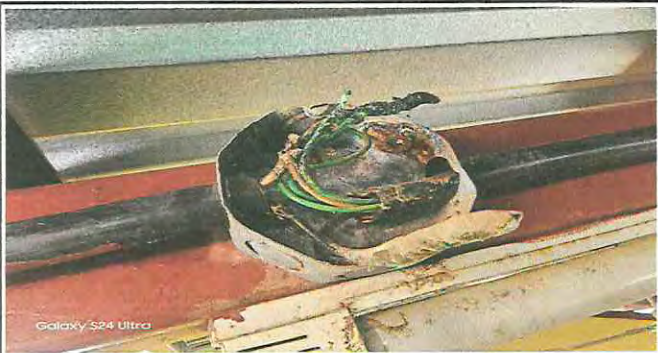
Foto1: Reparación del ducto eléctrico más accesorios.
