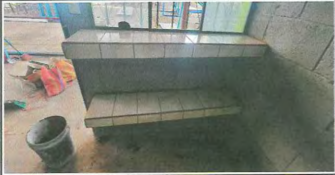
Foto 6: Reparación de mesones con azulejo
