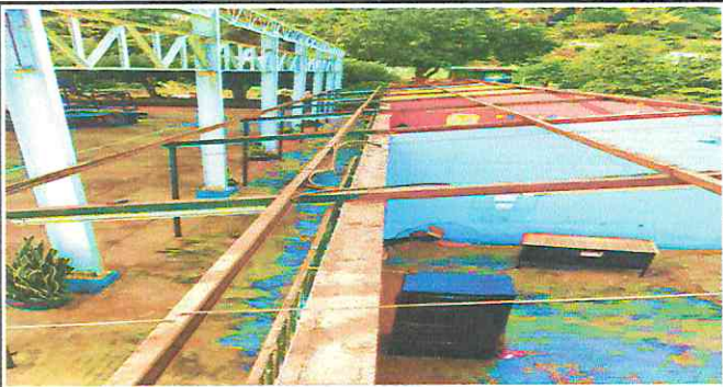
Foto1: Retiro de la lamina de zinc de aulas y cocina.
