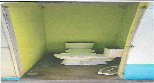
Foto 3: Sustitución de sanitarios con sus accesorios.
