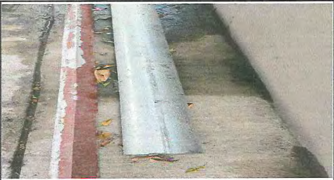
Foto 4: Sustitución de chimenea de metal
