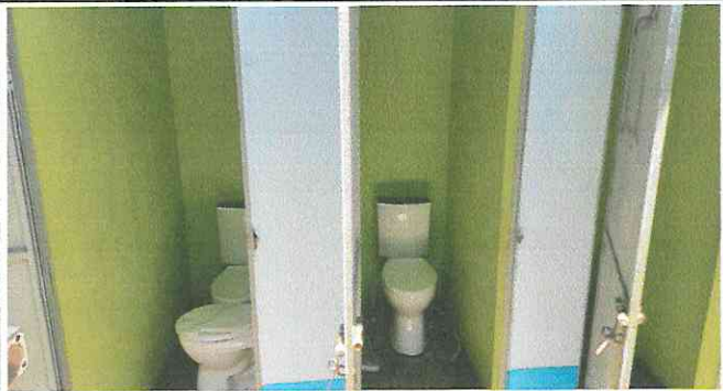
Foto1: Sustitución de sanitarios con sus accesorios.
