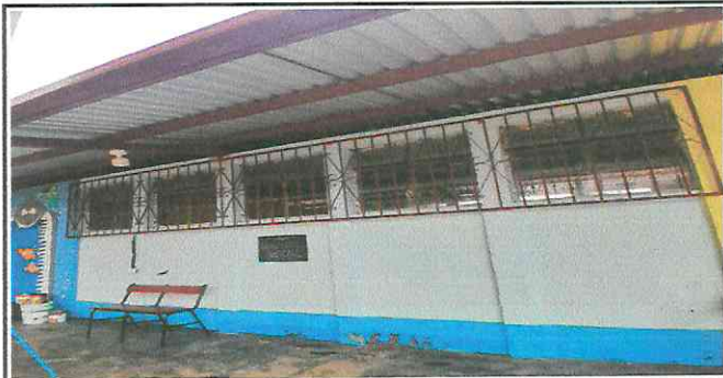
Foto 6: Pintura de balcones de aulas y cocina.
