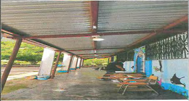
Foto 4: Reparación del ducto eléctrico más accesorios.
