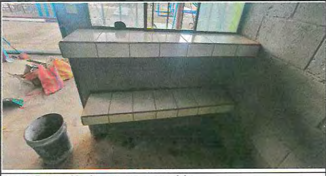
Foto 6: Reparación de mesones con azulejo
