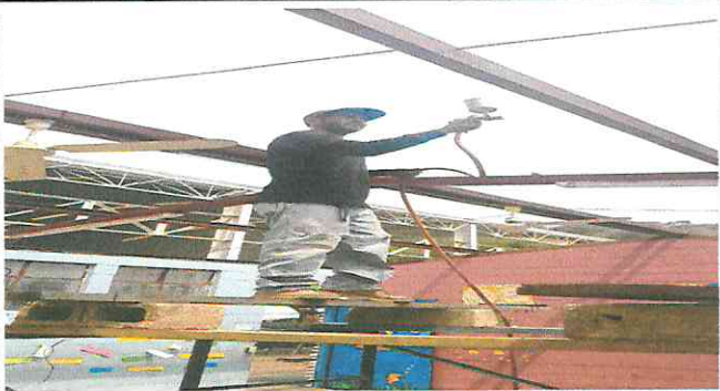
Foto 2: Mantenimiento de estructura de soporte
