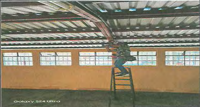
Foto 2: Reparación del ducto eléctrico más accesorios.
