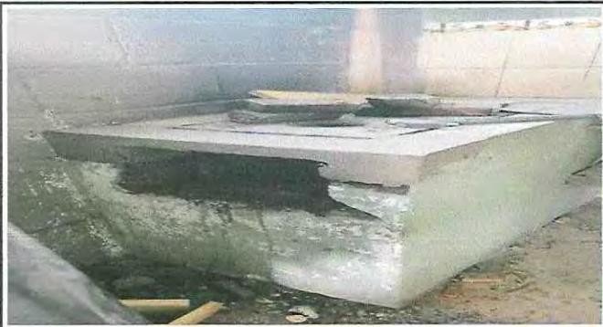
Foto1: Reparación de estufa rural con sus accesorios
