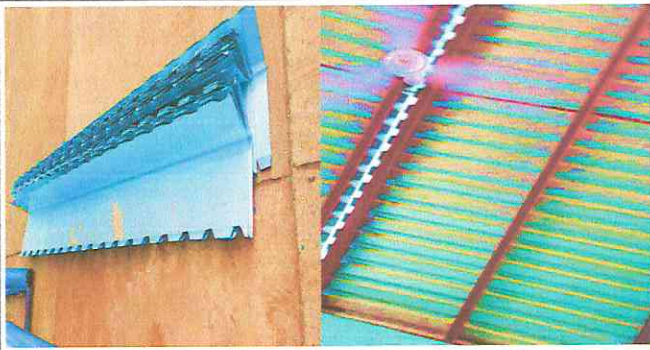
Foto 4: Sustitución de los capotes de lamina.
