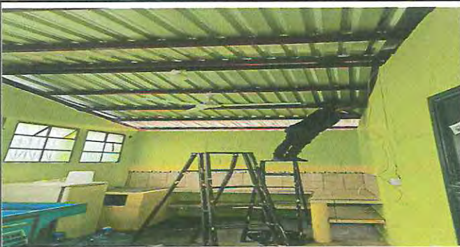
Foto 3: Reparación del ducto eléctrico más accesorios.
